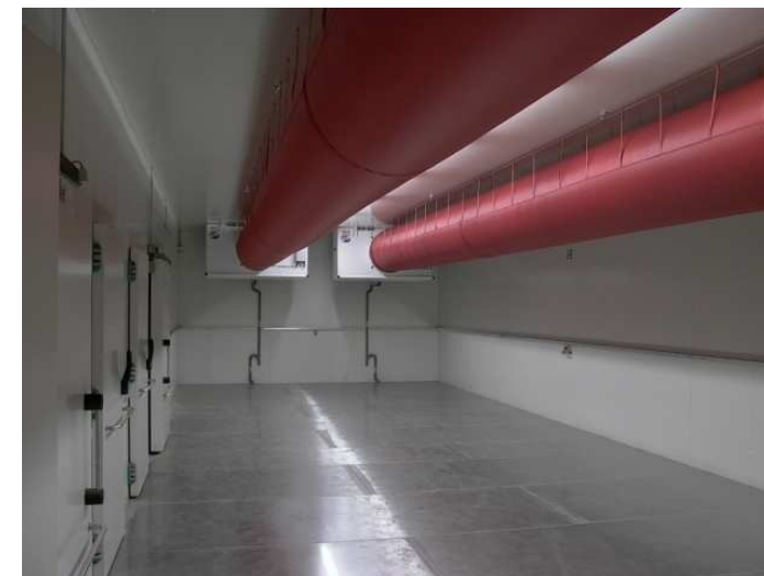
COOLANT®-Luftleitsystem für offene Tiefkühlagerung ohne Trocknung und Oberflächenverhautung der Teiglinge
