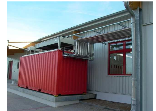
COOLANT®-Containermaschinenraum für schnelle und normgerechte Maschinen- und Verflüssigeraufstellung
